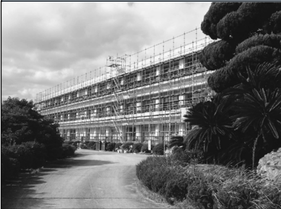
改修中の新国東中学校（旧国東高校）
